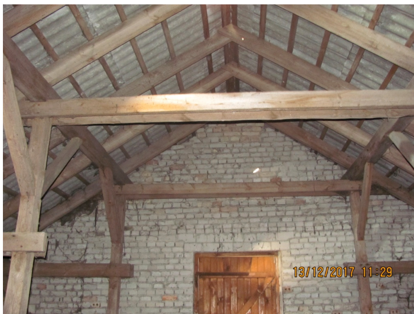
Więźba dachowa od strony ściany szczytowej pokazanej na Fot. Widoczne kleszcze 13,5 x 5,5 cm oraz krokwie K1 głównie 7x14 cm i rozstawie zmiennym jak pokazano na załączonym schemacie –rys.1
