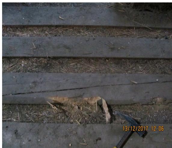
Deski podłogi – uszkodzone przez Kołatki
