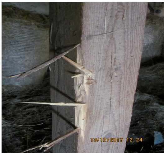
Słup –uszkodzony przez Kołatki
