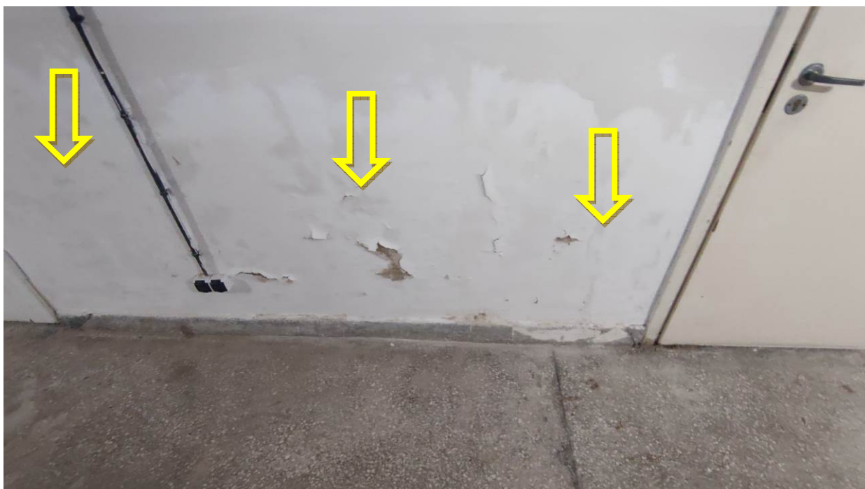
Zdjęcie nr 06 – Zawilgocenie ściany wewnętrznej przy posadzce w piwnicy
