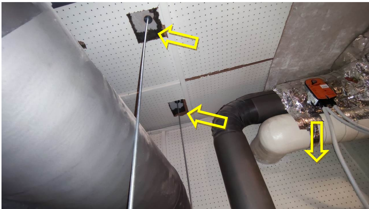
Zdjęcie nr 03 – Obudowa dzwękochłonna z wełny mineralnej i płyty pilśniowej w pomieszczeniu wentylatorowni
