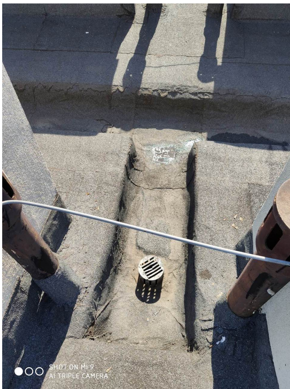
Zdjęcie nr 03 – Widok koryta odwadniającego
