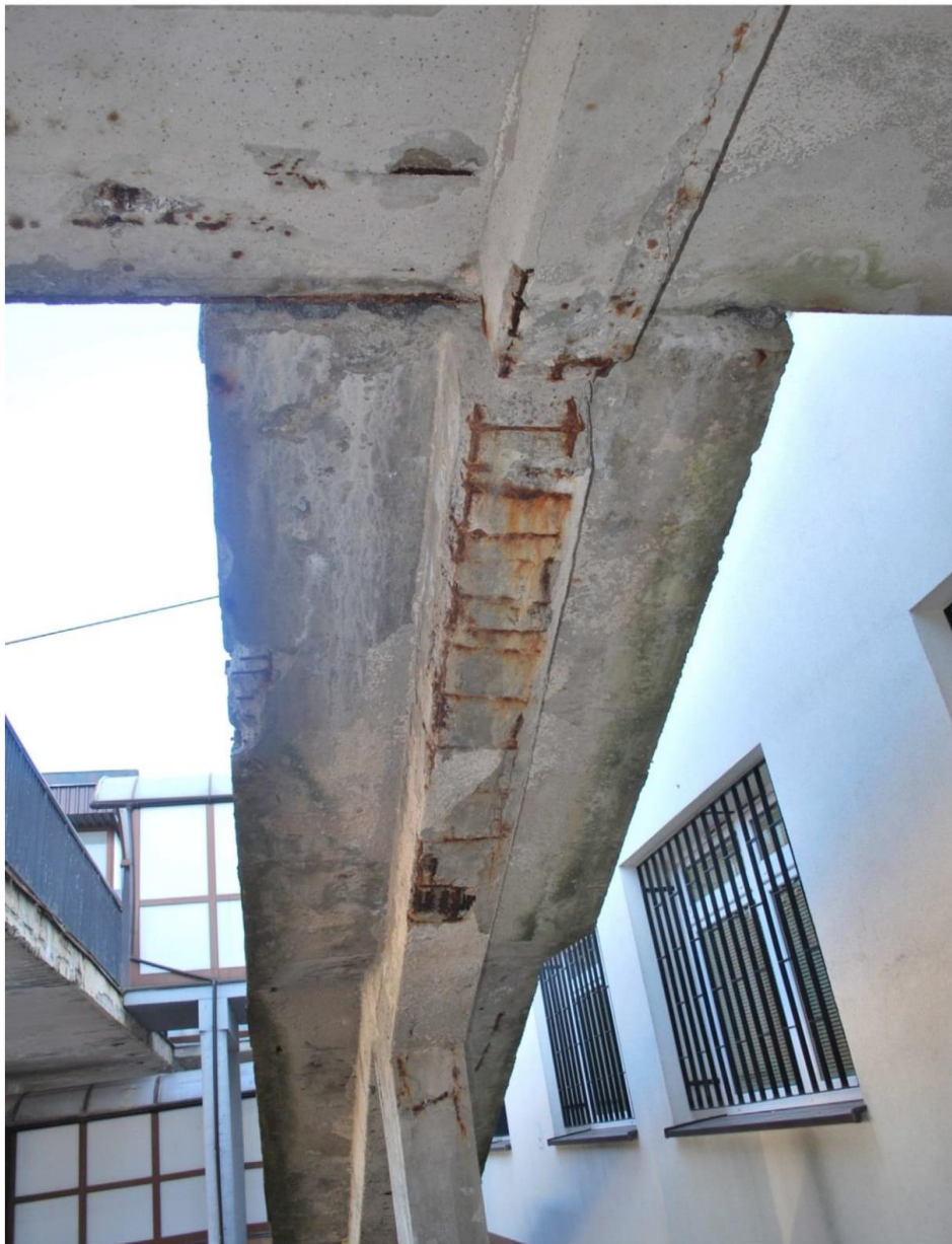
Belka schodów – odpadnięcie otuliny, korozja zbrojenia. Oblupywanie betonu na krawędzi płyty schodów.
