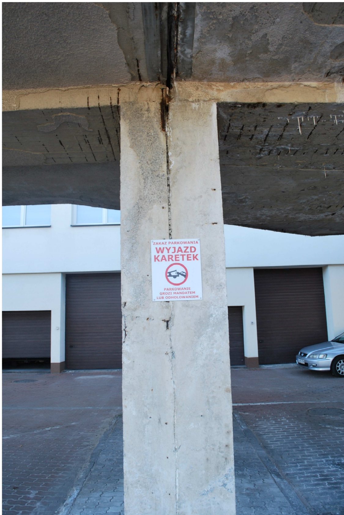
Słupy – brak tynku, stan techniczny dostateczny.
