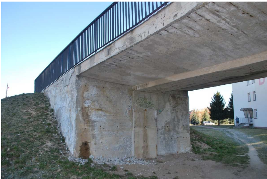
Przyczółki – brak tynku, stan betonu dostateczny.
