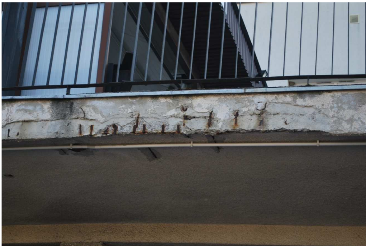
Krawędzie płyt wspornikowych przęsła – odsłonięcie prętów zbrojeniowych i ich korozja.
