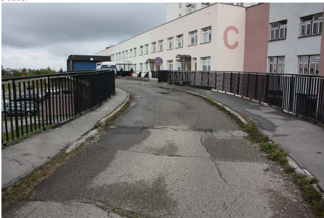
Nawierzchnia asfaltowa – pęknięcia nawierzchni, zapadnięcie na krawędzi przyczółku. Kruszenie się krawężników. Naciekanie asfaltu lanego.
