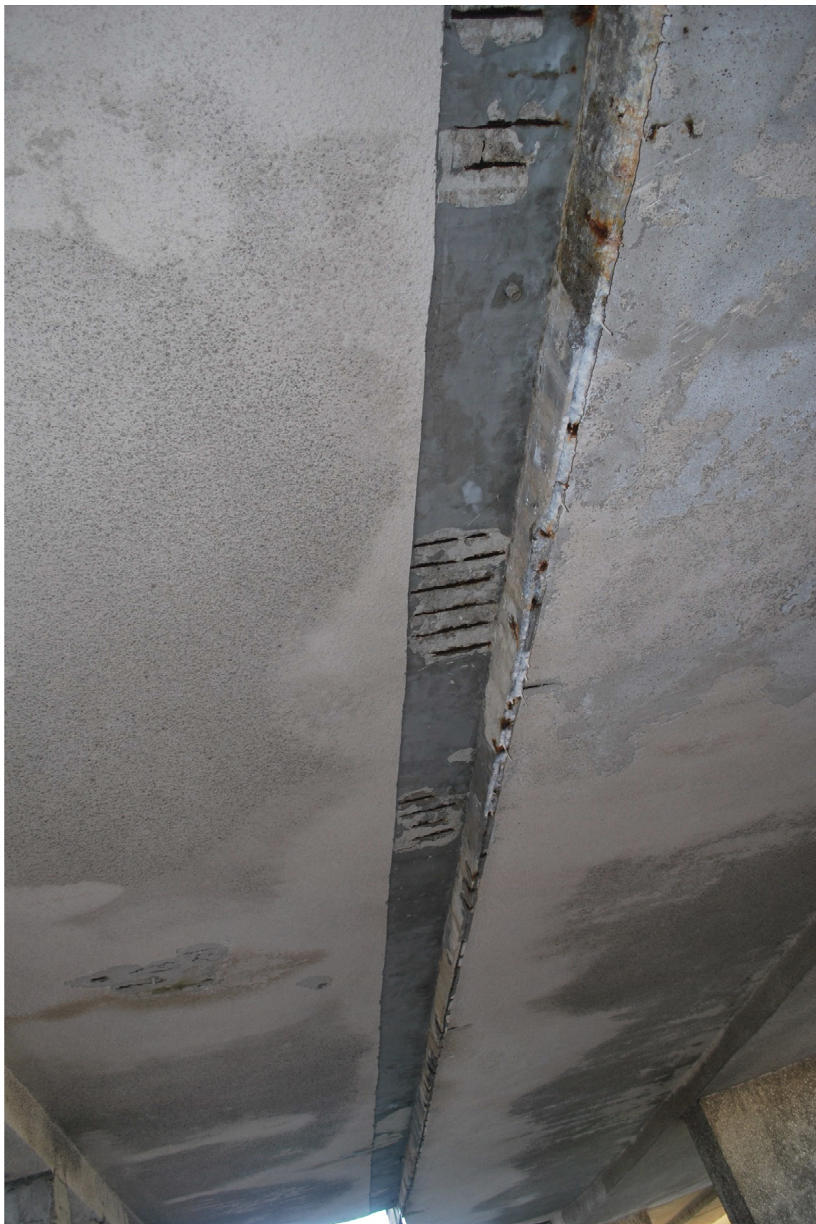
Płyta stropowa łącznika – miejscowe ubytki betonu otulającego dolne pręty zbrojeniowe.
