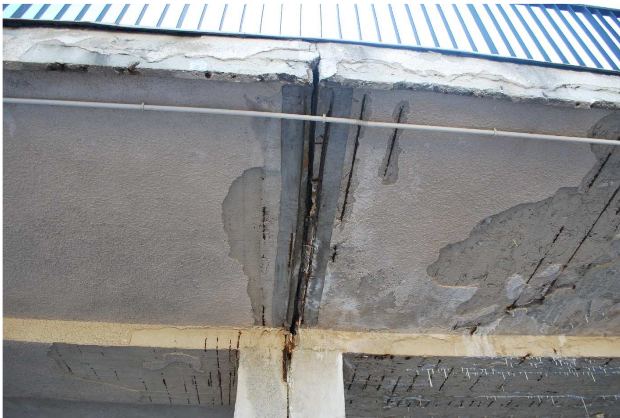
Dylatacja – erozja betonu, odsłonięcie zbrojenia.
