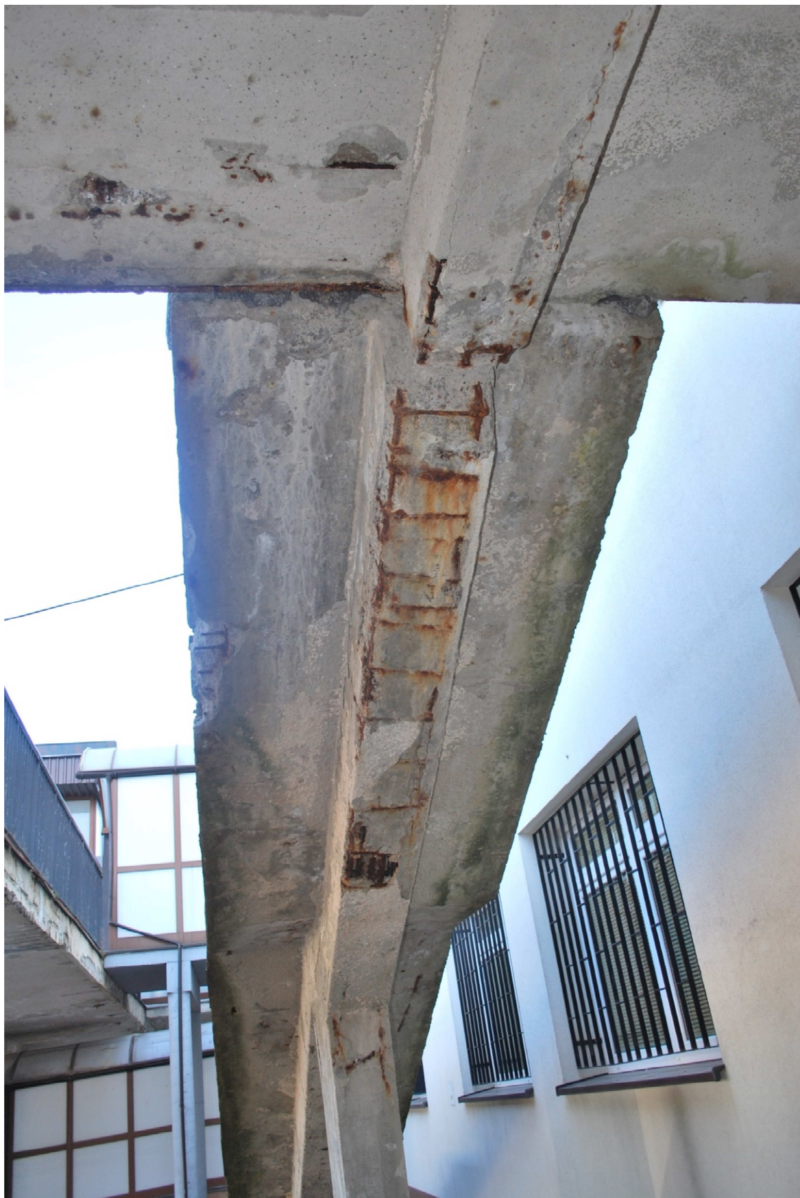
Belka schodów – odpadnięcie otuliny, korozja zbrojenia. Obłupywanie betonu na krawędzi płyty schodów.
