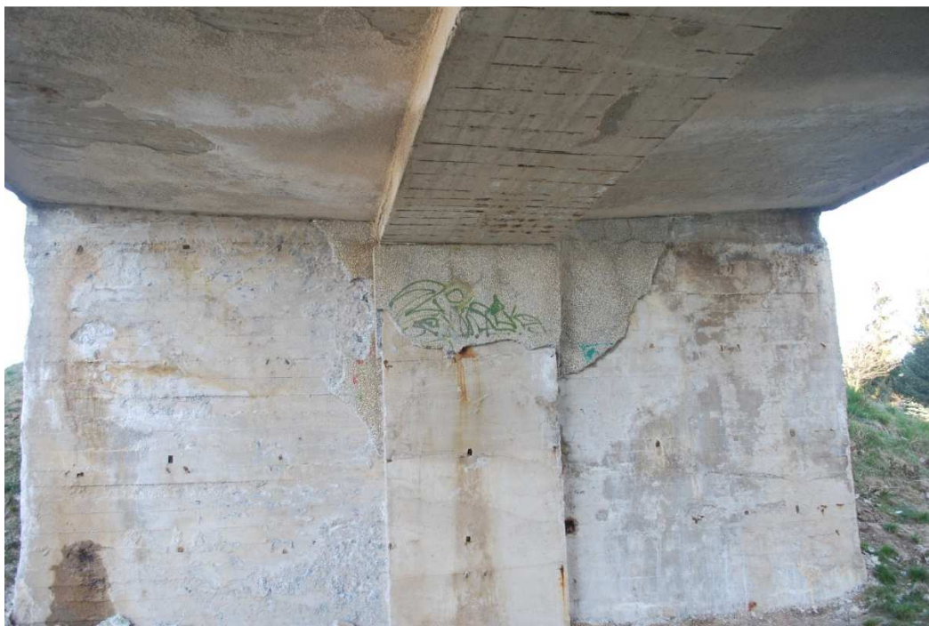
Przyczółki – brak tynku, stan betonu dostateczny.
