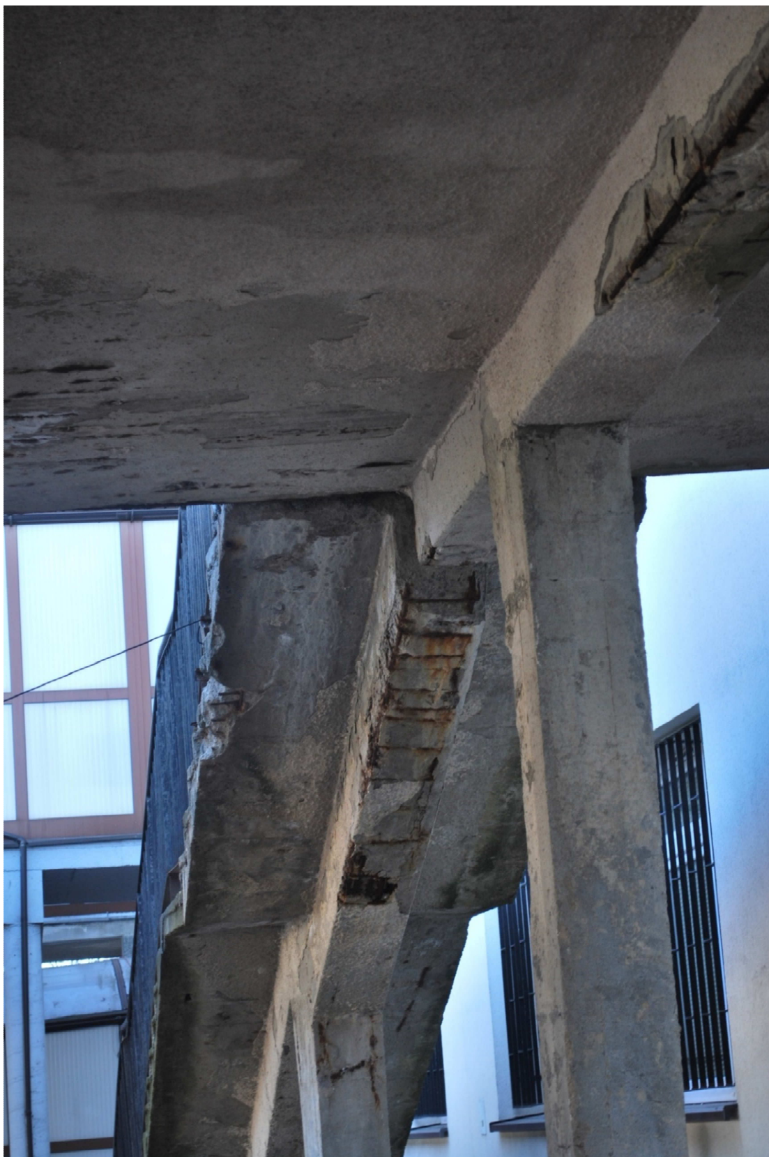
Podciąg łącznika, słupy schodów i łącznika – odpadnięcie otuliny zbrojenia (podciąg), korozja prętów.
