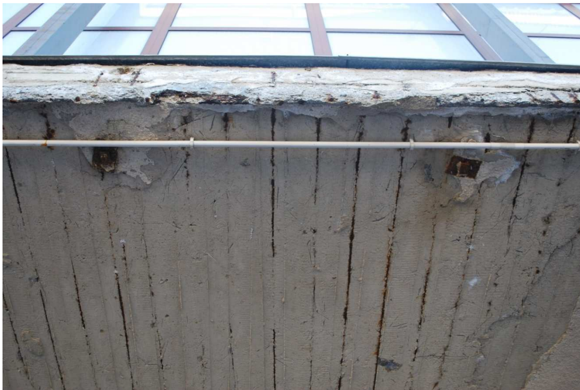
Spód płyty podjazdu – odpadnięcie tynku, odsłonięcie zbrojenia, korozja prętów.
