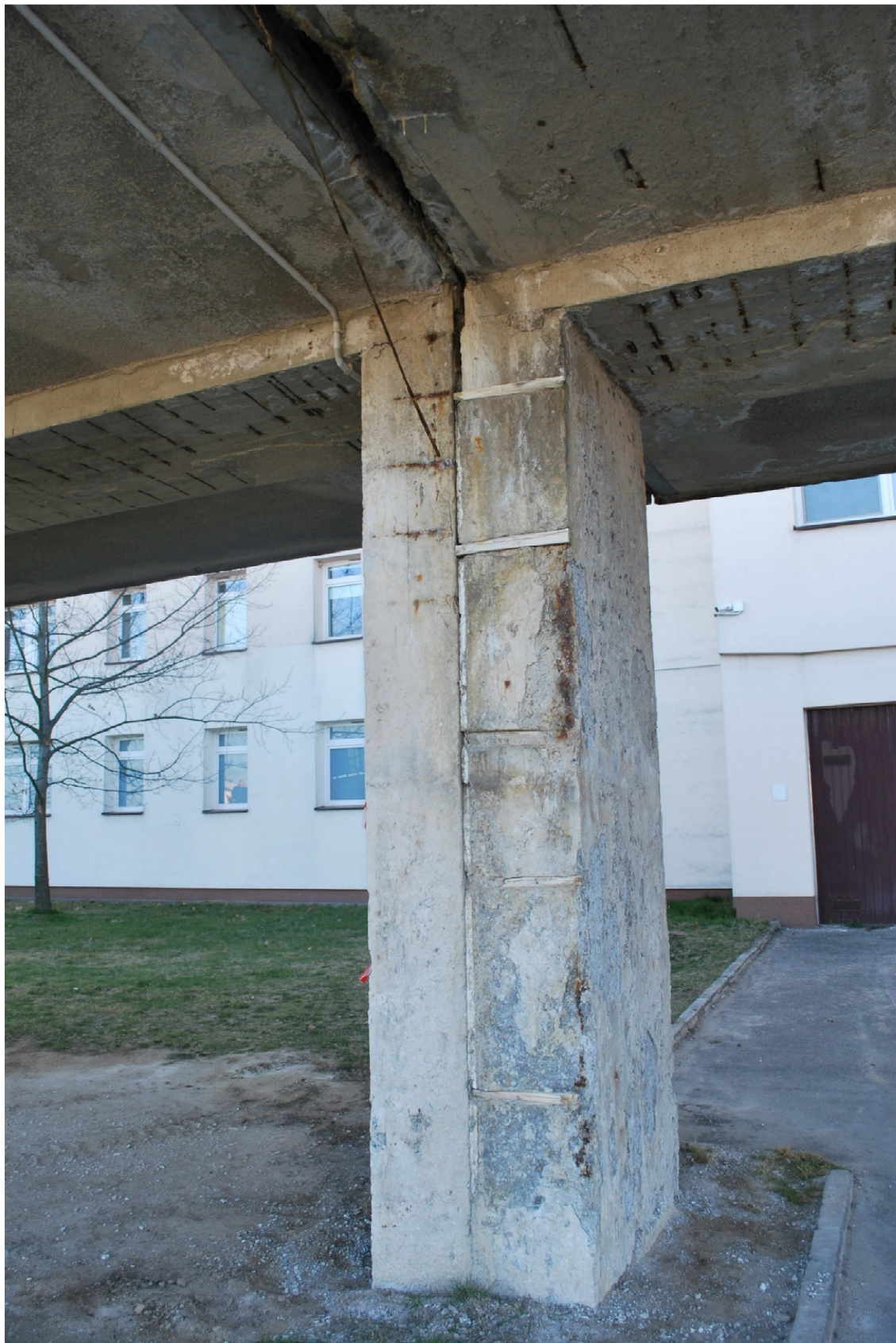
Słupy – brak tynku, stan techniczny dostateczny.
