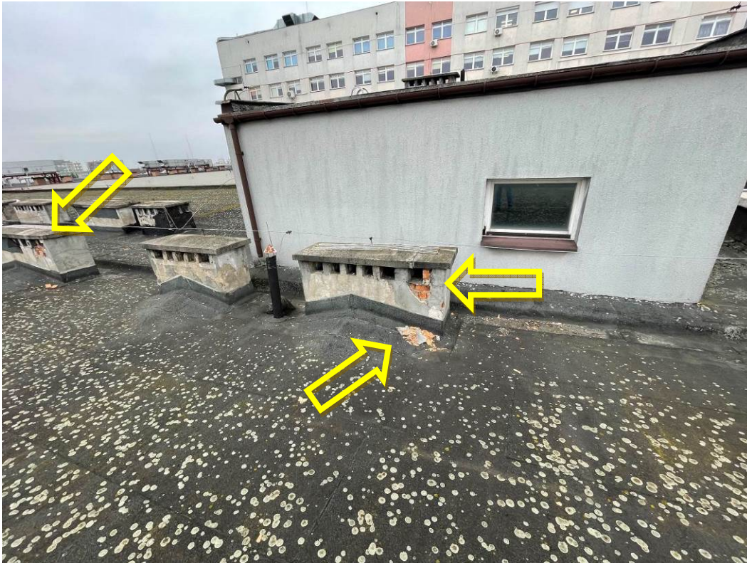
Zdjęcie nr 11 Mchy i porosty na pokryciu z papy; pęknięcia i łuszczenie się cegieł oraz odspojenia tynków na kominach
