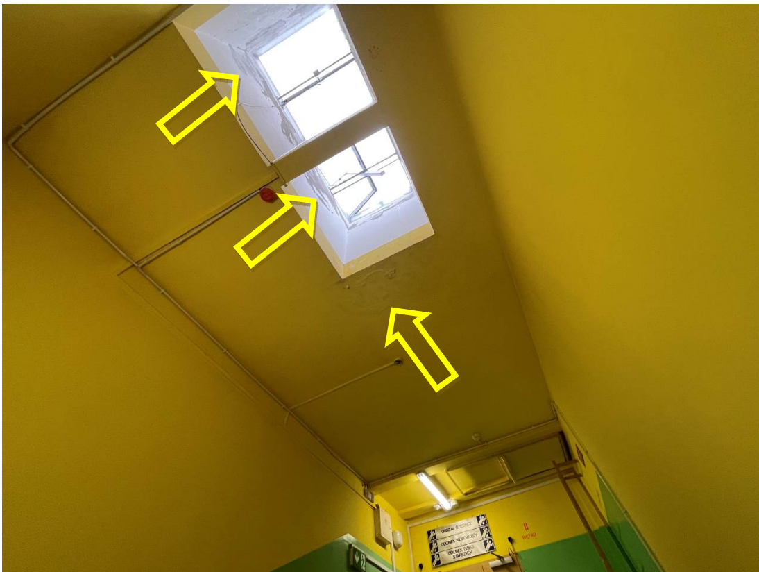
Zdjęcie nr 16 Widok stropu nad klatką schodową 2.02; widoczne przebarwienia, puchłe i odspojenia tynków przy świetliku spowodowane nieszczelnym pokryciem dachu
