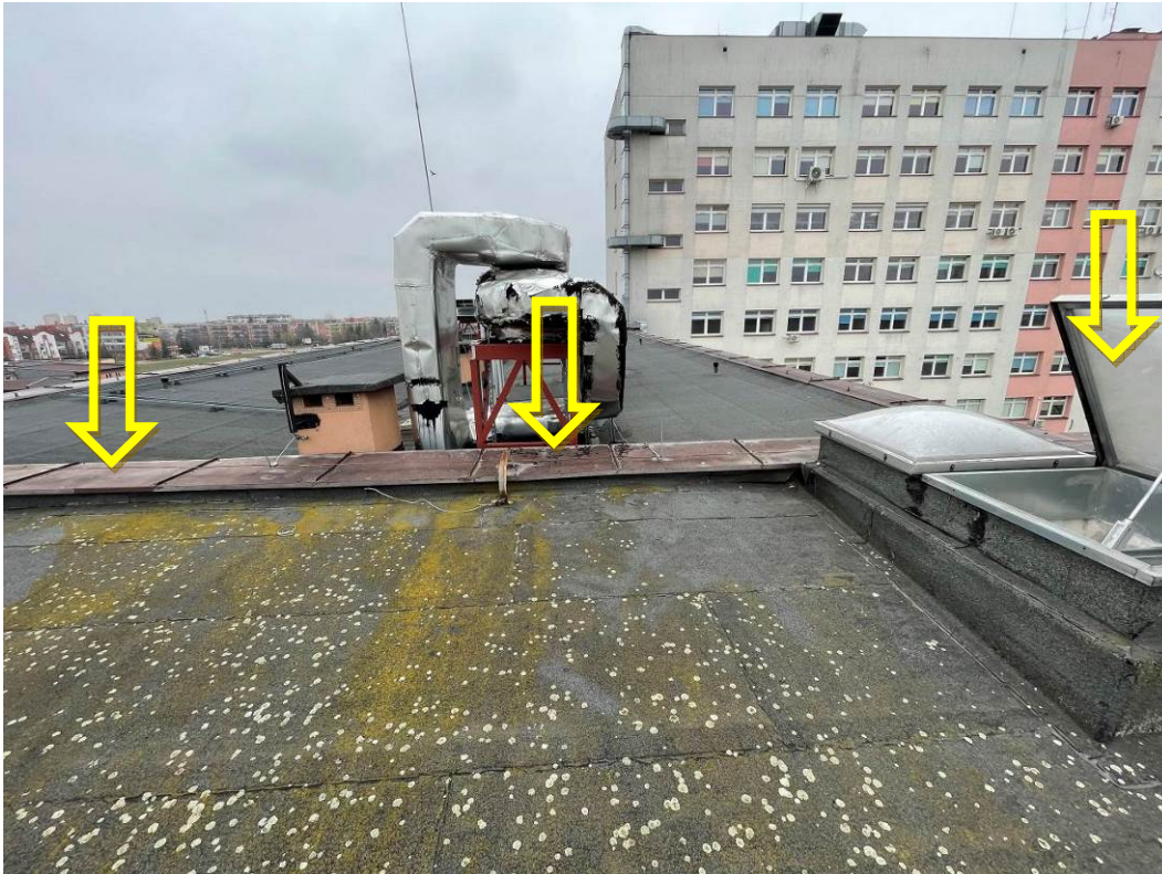
Zdjęcie nr 04 Mchy i porosty na pokryciu z papy; otwarta kłapa dymowa; skorodowane obróbki blacharskie ściany attykowej
