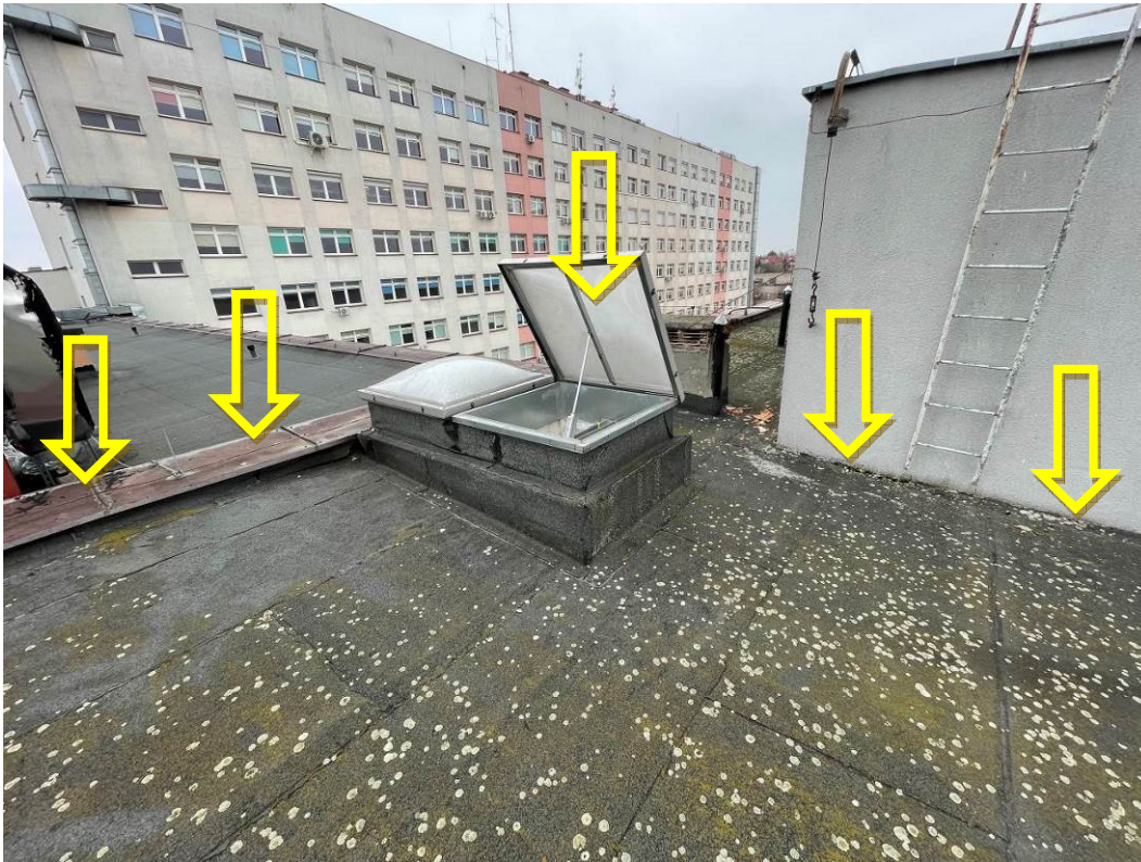
Zdjęcie nr 03 Mchy i porosty na pokryciu z papy; otwarta kłapa dymowa; skorodowane obróbki blacharskie ściany attykowej; brak obróbek przy ścianie kondygnacji technicznej
