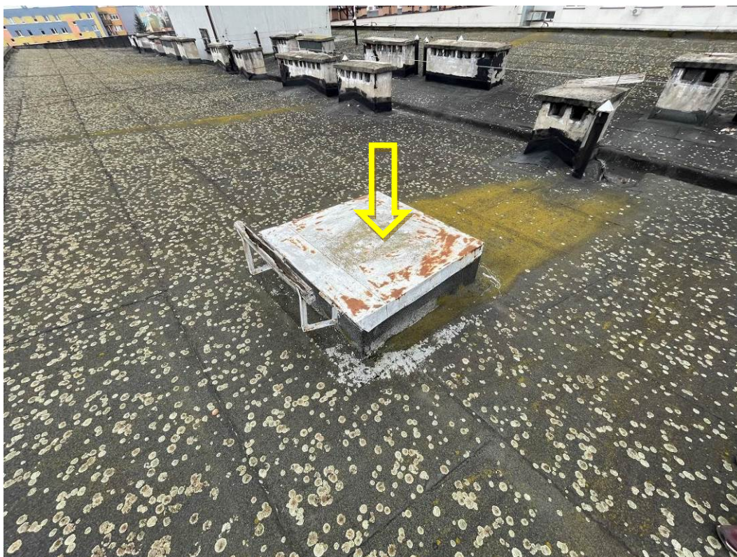
Zdjęcie nr 10 Mchy i porosty na pokryciu z papy; skorodowane pokrycie z blachy wylazu dachowego
