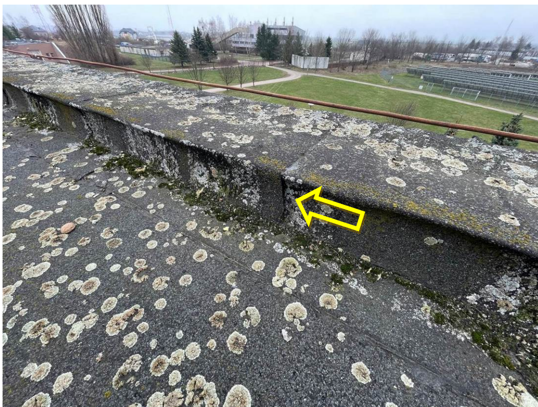
Zdjęcie nr 09 Mchy i porosty na pokryciu z papy; odspojenie pokrycia z papy przy ścianie attyki
