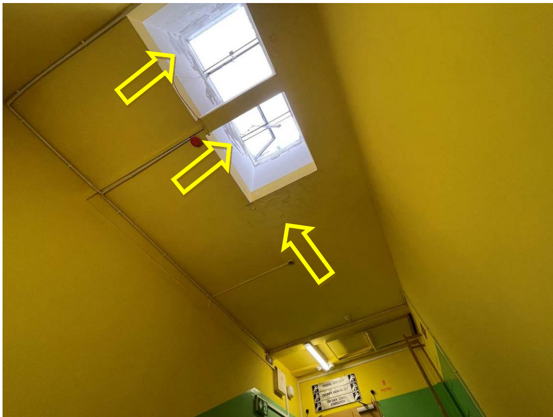
Zdjęcie nr 16 Widok stropu nad klatką schodową 2.02; widoczne przebarwienia, purchle
