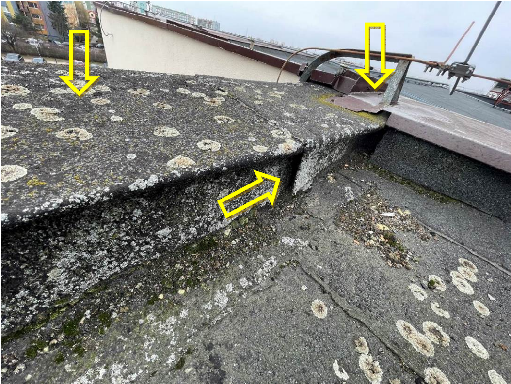
Zdjęcie nr 05 Mchy i porosty na pokryciu z papy; odspojenie pokrycia z papy przy ścianie zewnętrznej attyki
