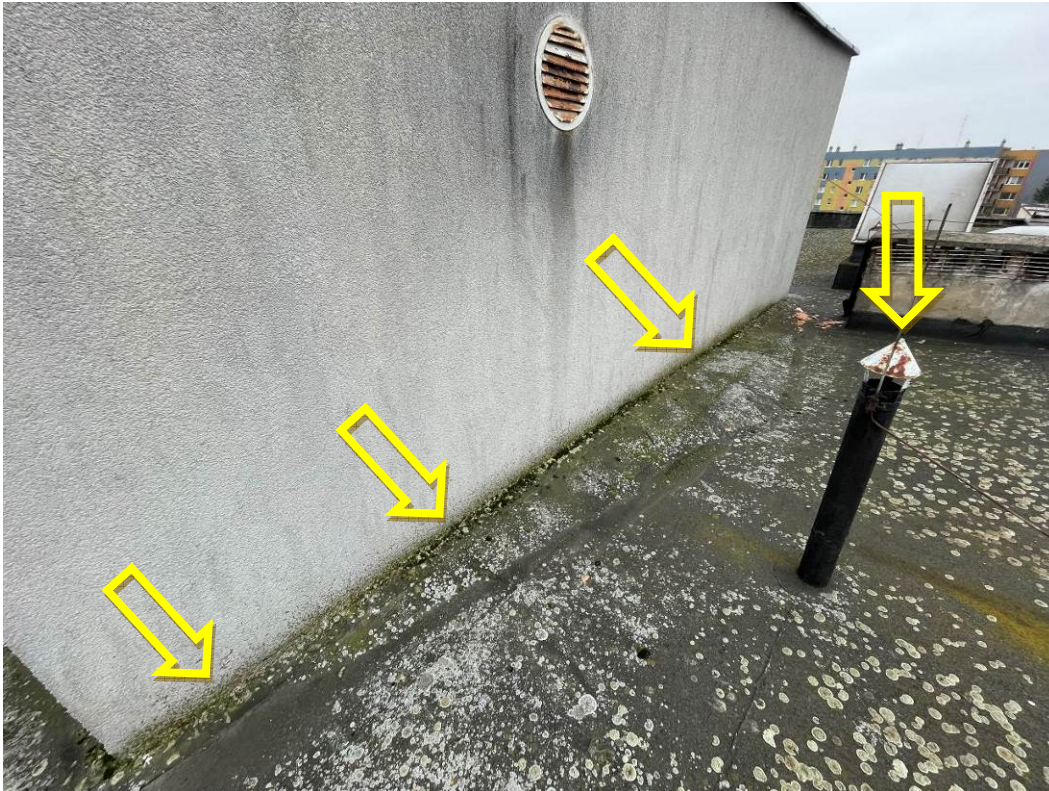
Zdjęcie nr 12 Mchy i porosty na pokryciu z papy; skorodowane wywiewka dachowa; brak obróbek w płaszczyźnie dachu przy pomieszczeniu technicznym
