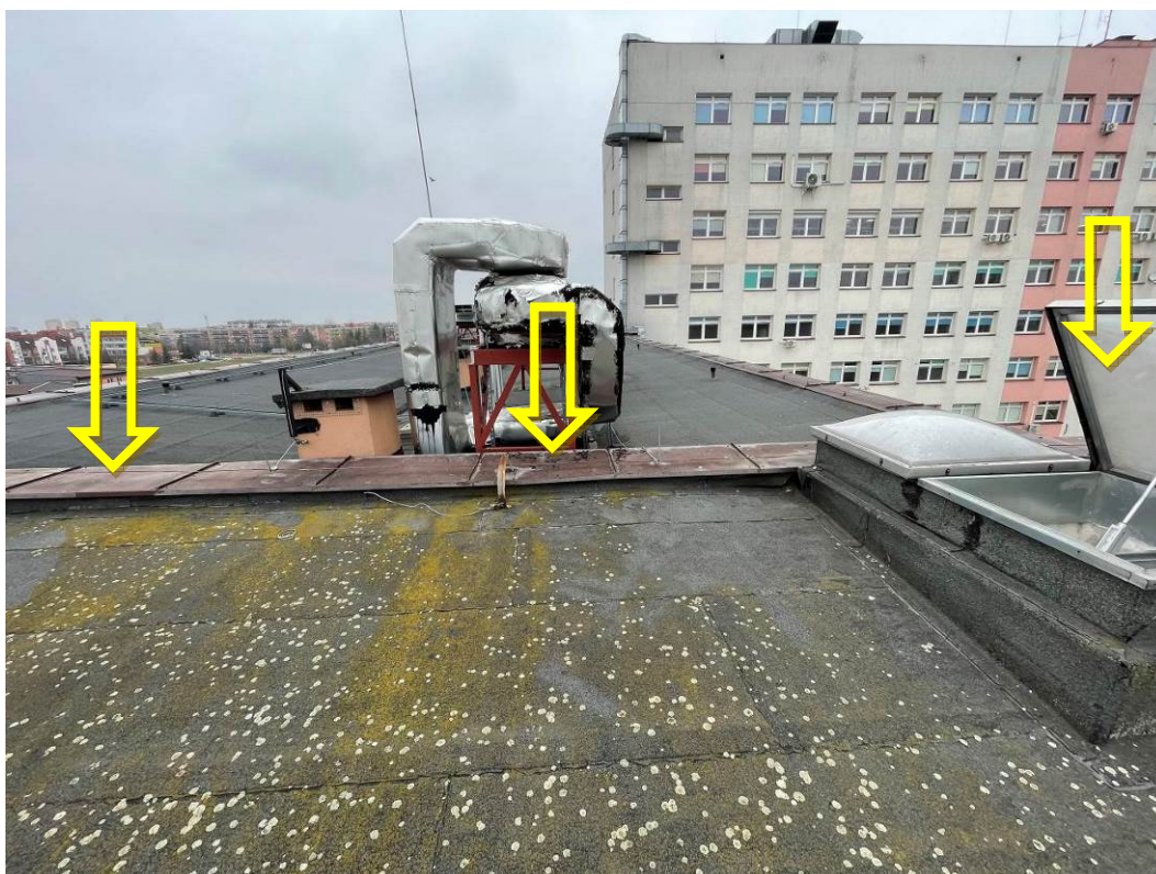
Zdjęcie nr 04 Mchy i porosty na pokryciu z papy; otwarta kłapa dymowa; skorodowane obróbki
