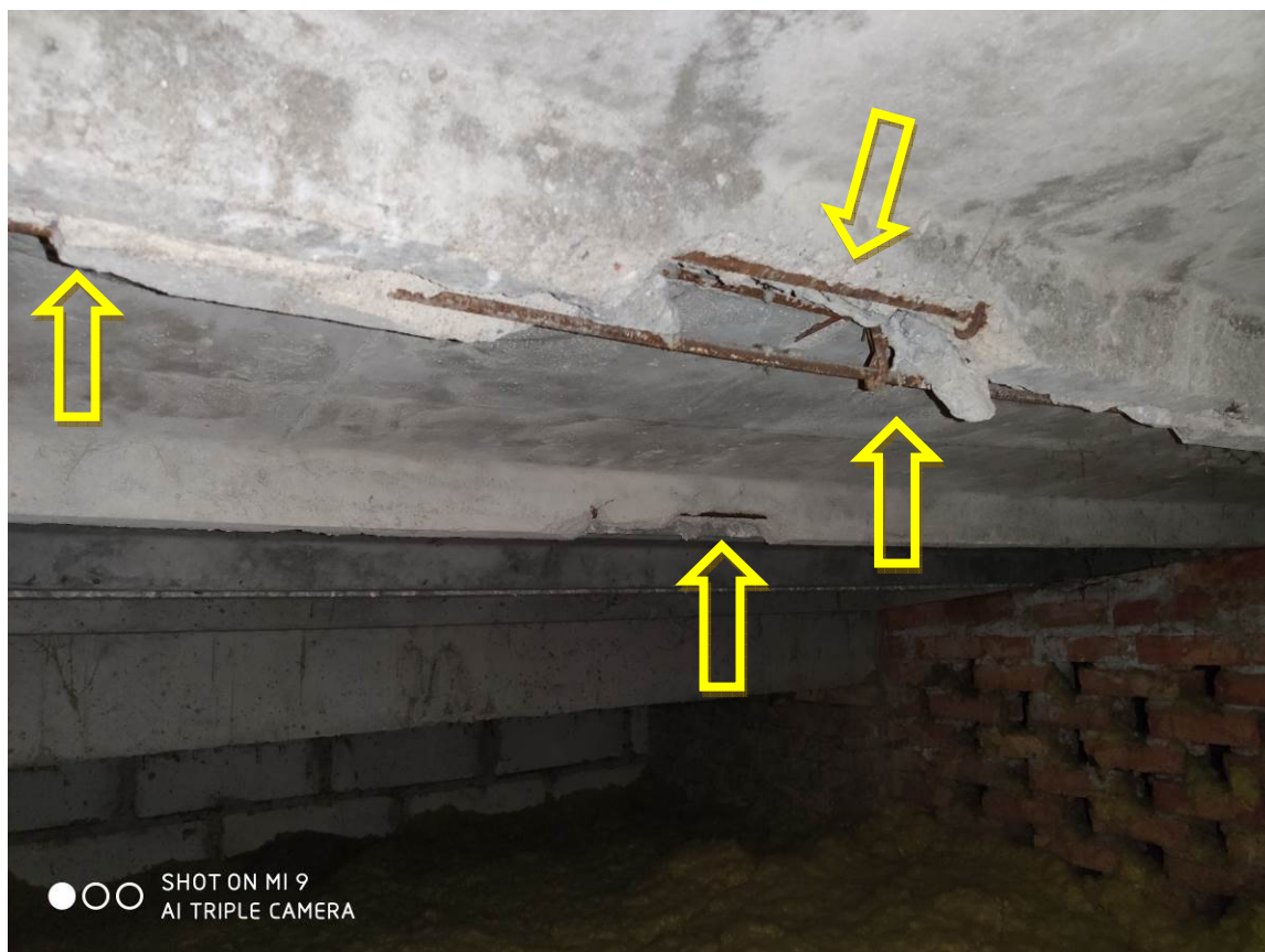
Zdjęcie nr 02 – Uszkodzenia płyt korytkowych w strefie wentylowanej stropodachu
