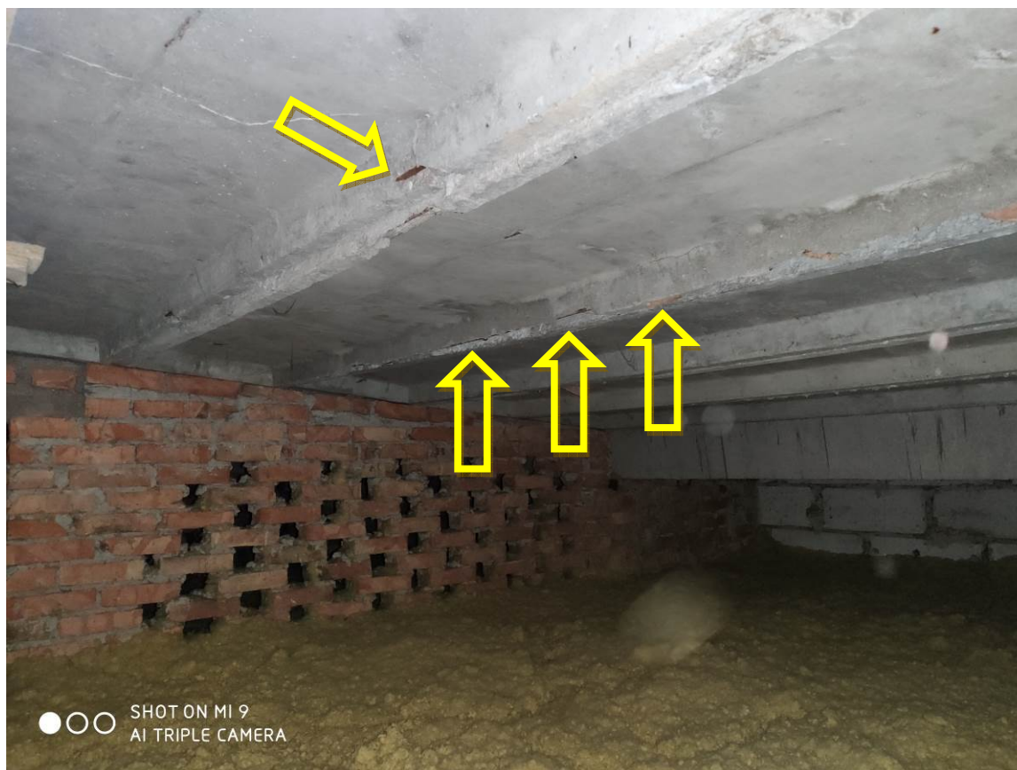
Zdjęcie nr 03 – Uszkodzenia płyt korytkowych w strefie wentylowanej stropodachu
