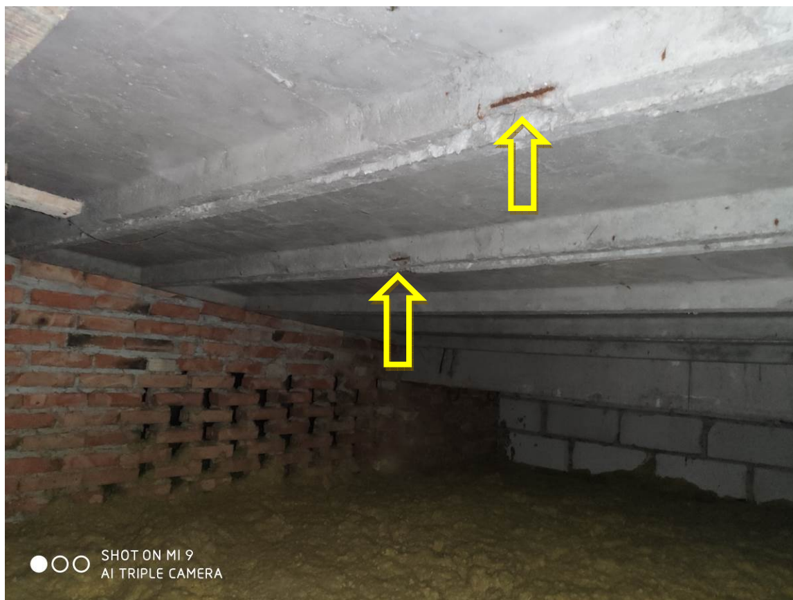
Zdjęcie nr 04 – Uszkodzenia płyt korytkowych w strefie wentylowanej stropodachu
