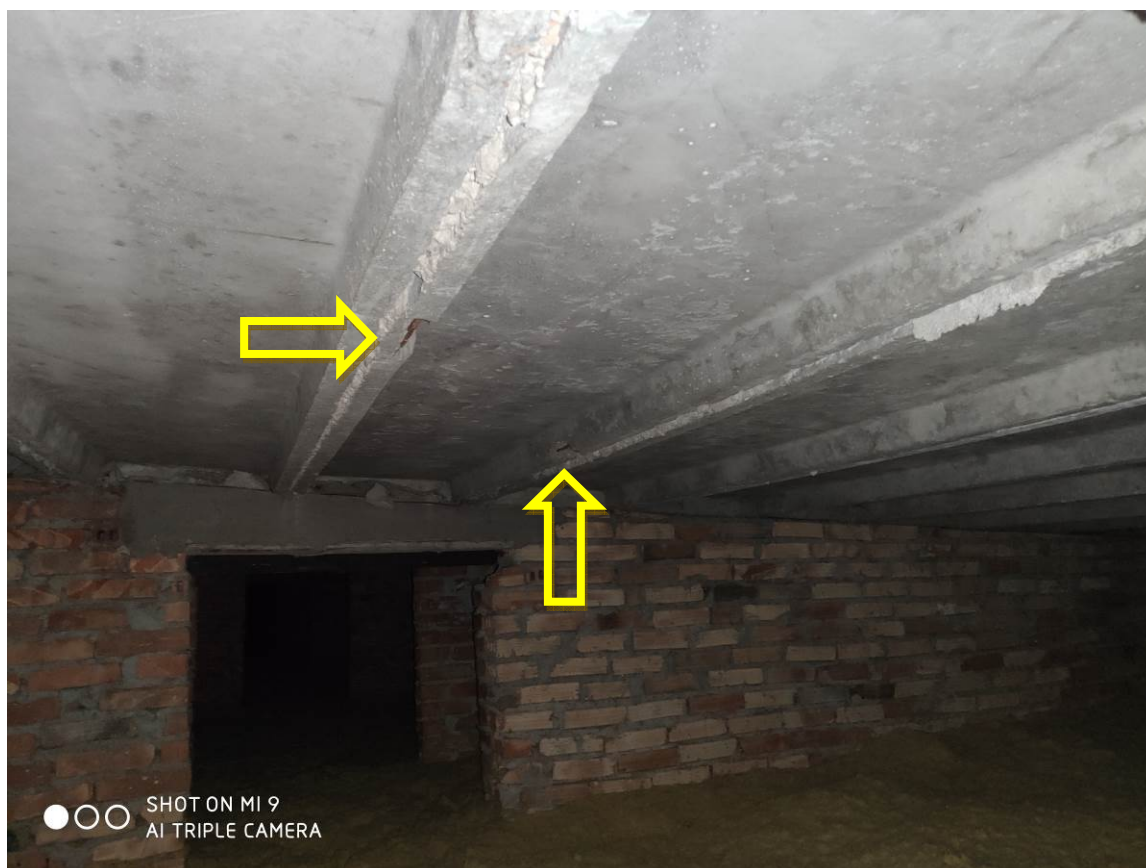
Zdjęcie nr 05 – Uszkodzenia płyt korytkowych w strefie wentylowanej stropodachu
